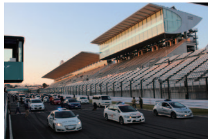
熱いイベントの余韻が残る国際レーシングコースをご自分の車で体験走行いただいた「マイカーラン」 (8日)。
